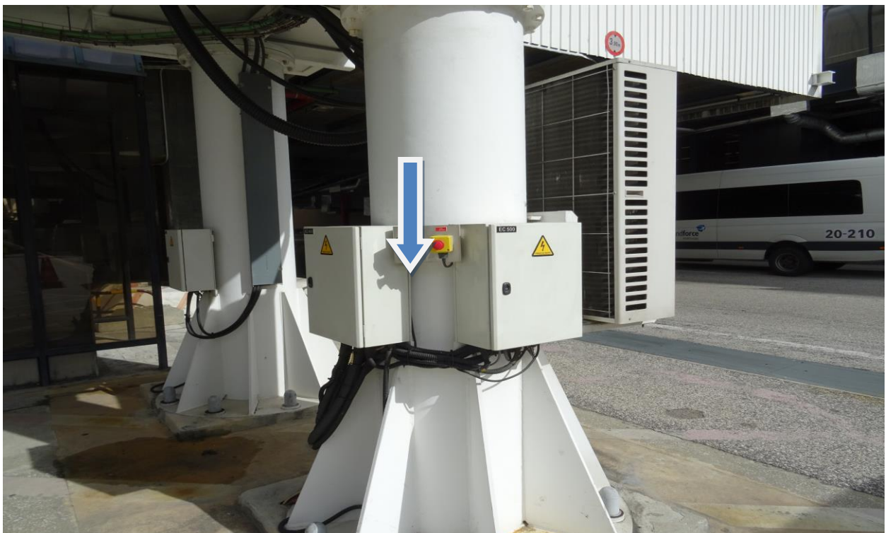
Figura 13 - Botão de acionamento do aviso de avião calçado (chocks on) || Figure 13 - The power button airplane chocks on
