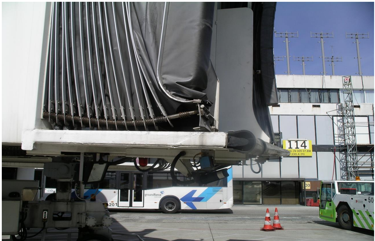
Figura 8 - Ponte de desembarque no stand 114 || Figure 8 - Air bridge on stand 114
