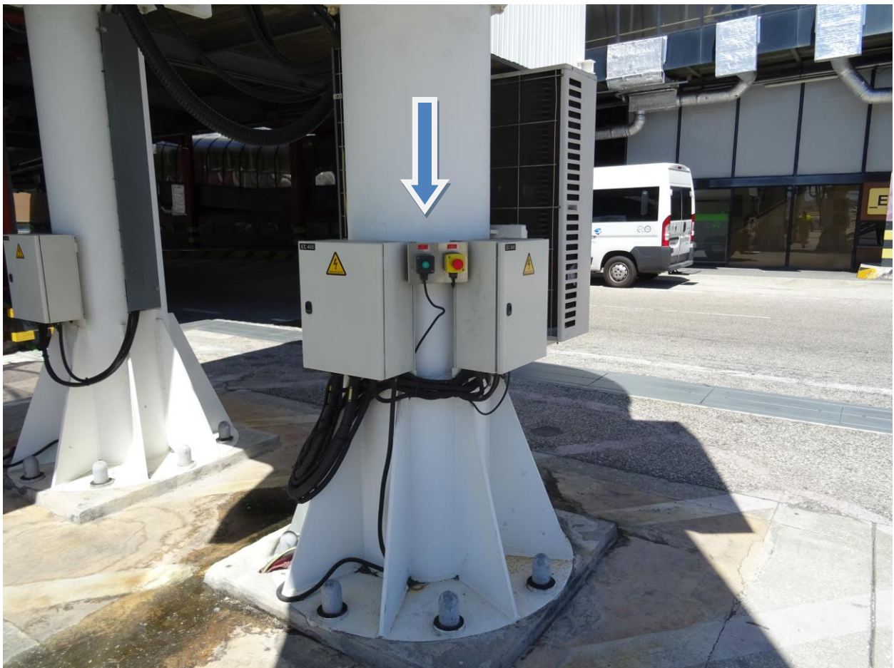
Figura 16 - Botão de acionamento do aviso de avião calçado (“chocks on”) || Figure 16 - The activating button for airplane “chocks on”
