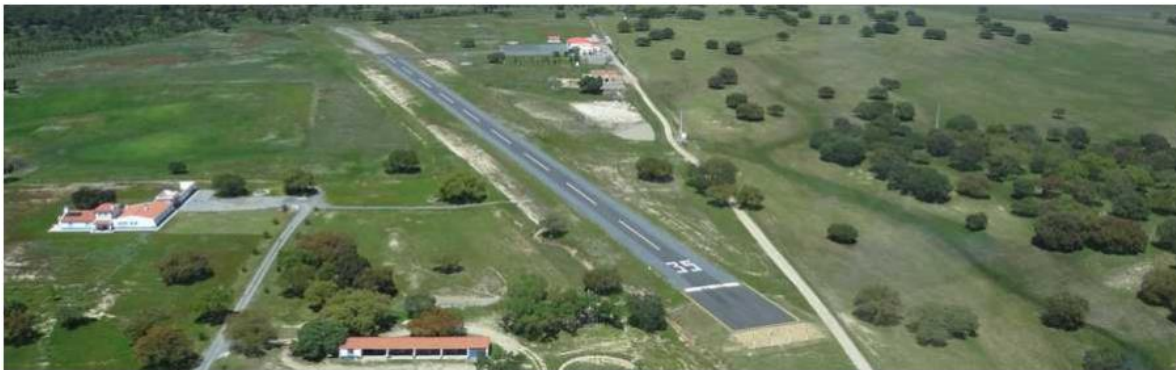
Figura 18 || Figure 18 Aeródromo de Figueira de Cavaleiros (LPFC) || Aerodrome of Figueira de Cavaleiros (LPFC)
