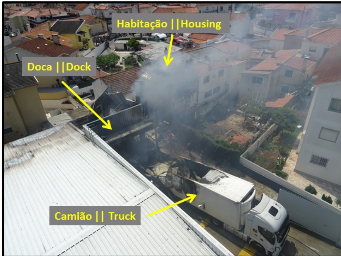
Figura 5 || Figure 5 Outros danos || Other damage
