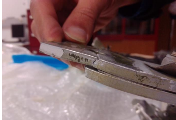
Figura A– Detalhe da zona fraturada da mesa inferior traseira da longarina (vista de baixo).
